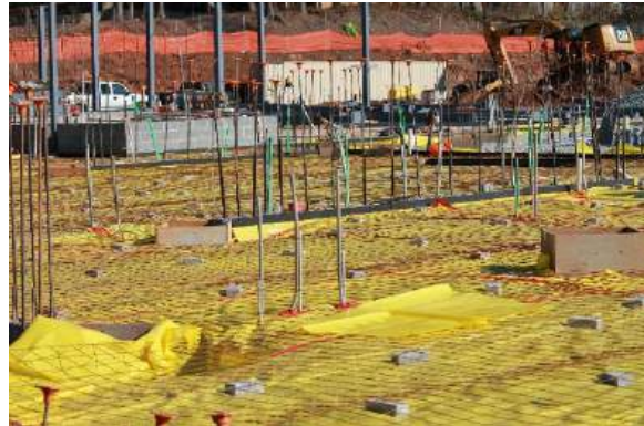
Slab on grade pour preparation
