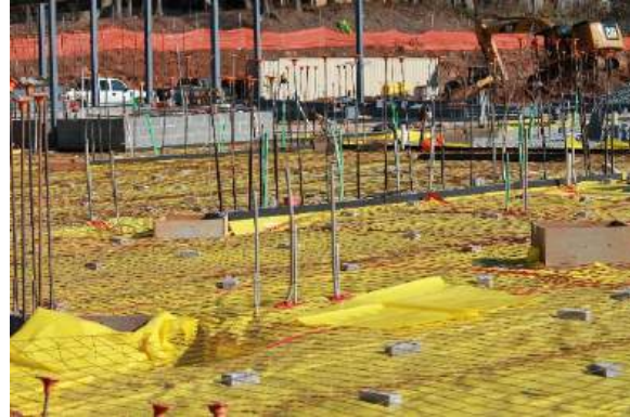
Slab on grade pour preparation
