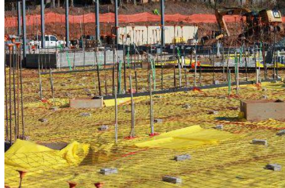
Slab on grade pour preparation
