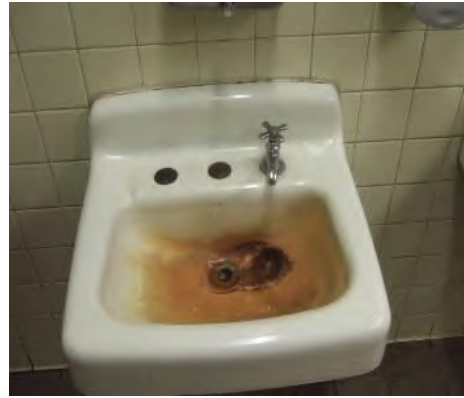
Rockbridge ES Existing Sink
