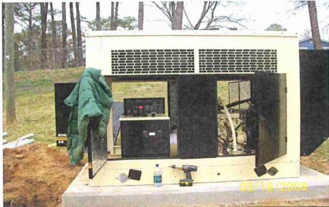
Jolly ES New Generator
